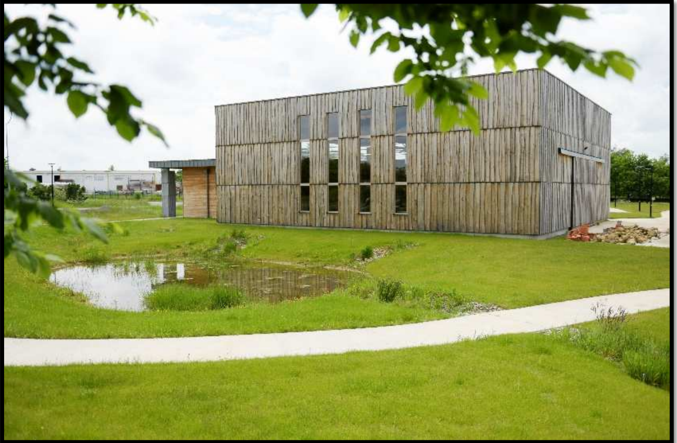
Figure 33 : Photo du bâtiment d'Ecobatys
