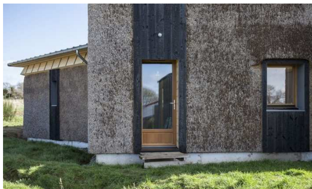
Figure 19 : Photo d'une maison couverte en roseau à Saint-Nolff (Morbihan)
