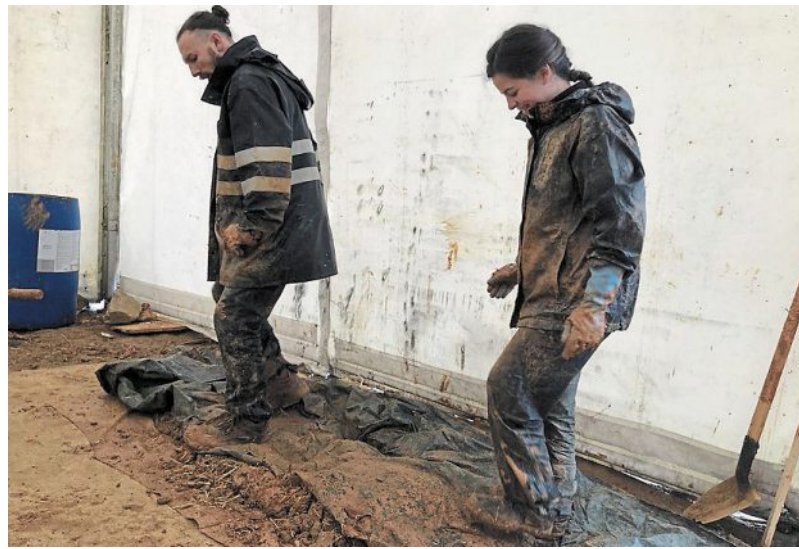
Les étudiants piétinent la terre avant de la transvaser dans des moules à briques.
